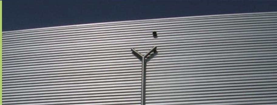
Das Sandwichelement mit gewellter Außendeckschale und einer Fugengeometrie für verdeckte Befestigung lässt Fassaden durch das Licht-Schattenspiel des Wellprofils sehr lebendig erscheinen. Die hochdämmende Eigenschaft des FCKW- und HFCKW-freien Polyurethan-Dämmkerns erfüllt bei weitem die heutigen Anforderungen an den Wärme- und Feuchteschutz. Ein im Längsstoß angeschäumtes, unverrutschbares Dichtband schließt die Fuge schlagre-
